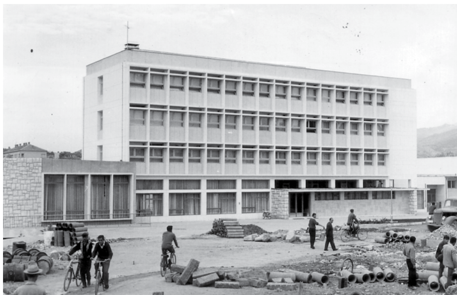
Slika 3. Dom JNA u Podgorici – Izgradnja prilaznog platoa ispred glavnog ulaza.
